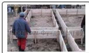
Строительство опалубки
