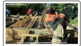
Фундамент ТИСЭ. Заливка
