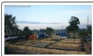
Фундамент ТИСЭ. Опалубка
