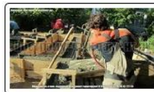
Фундамент ТИСЭ. Заливка фундамента
