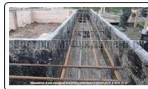
Армирование фундамента по технологии ТИСЭ
