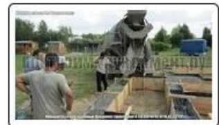
Заливка фундамента миксером
