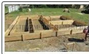
Установка опалубки под разметку
