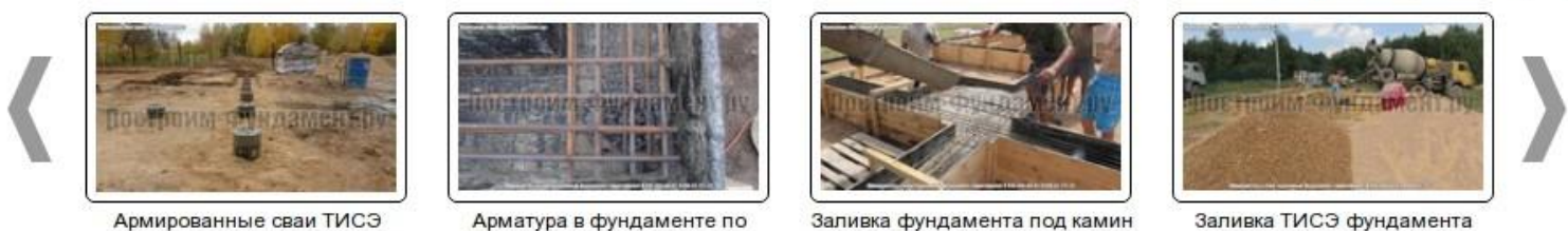
Армированные сваи ТИСЭ
