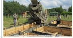
Фундамент ТИСЭ. Бетонирование фундамента
