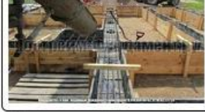
Арматура в фундаменте
