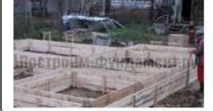
Строительство опалубки
