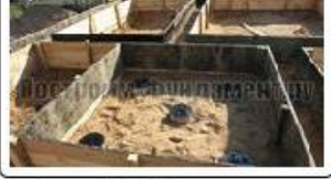
Сваи ТИСЭ под печь
