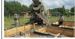
Фундамент ТИСЭ. Бетонирование фундамента
