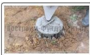
Бетонирование свай ТИСЭ
