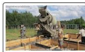
Заливка фундамента по технологии ТИСЭ миксером
