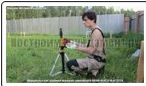
Разметка фундамента с применением лазерного нивелира
