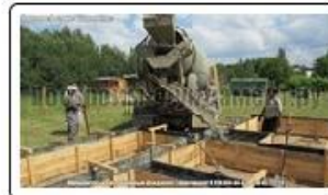
Фундамент ТИСЭ. Бетонирование фундамента
