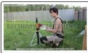
Разметка фундамента с применением лазерного нивелира
