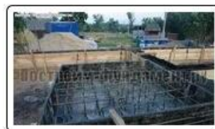
Армирование фундамента по технологии ТИСЭ
