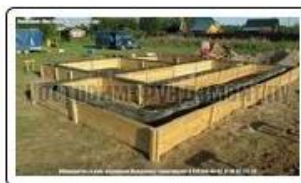
Установка опалубки
