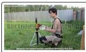
Разметка фундамента с применением лазерного нивелира
