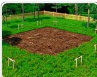
Для максимально точной разметки осей под столбчатый фундамент мы используем лазерный нивелир. Каждая ось отмечается в двух сторонах деревянными выносами, которые основательно забиваются в землю. Затем к горизонтальным перемычкам выносок крепится шнур, обозначающий ось. На участок необходимо вынести оси всех несущих стен и тяжёлых простенков, под которыми намечены сваи.
