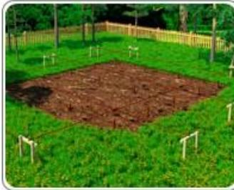
Разметка под столбчатый фундамент требуется с целью определения чёткого месторасположения свай. Столбы располагаются по всему периметру строения, на пересечении осей и вдоль осей с шагом 1,5–2,5 м. Места установки свай отмечаются колышками, забиваемыми в землю. Обычно в качестве колышков мы используем обрезки арматуры.
