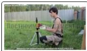
Разметка фундамента с применением лазерного
