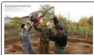
Бурение буронабивных свай под фундамент
