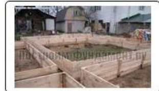
Установка опалубки
