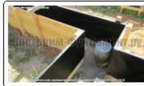
Опалубка прокладка стенок пергамином
