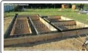
Опалубка, стенки покрыты рубероидом
