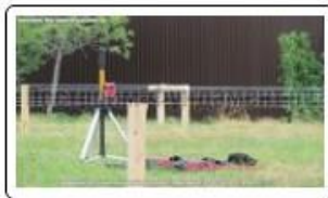
Разметка с применением лазерного нивелира
