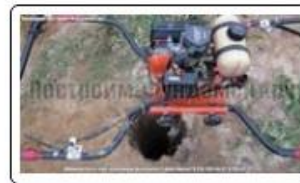
Мотобур для бурения свай
