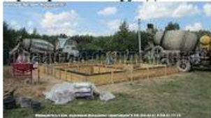
Бетонирование фундамента ТИСЭ
