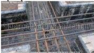
• Армирование фундамента по технологии ТИСЭ
