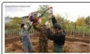
Бурение буронабивных свай под
