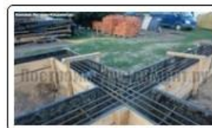
Арматура в фундаменте ТИСЭ
