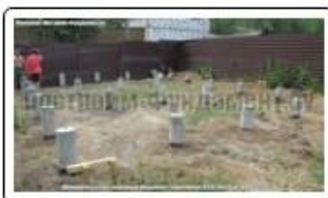
Сваи ТИСЭ, вывод из земли на 60-100 см
