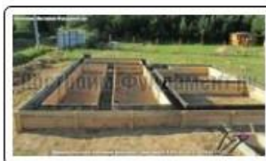
Фундамент ТИСЭ. Опалубка, прокладка стенок рубероидом
