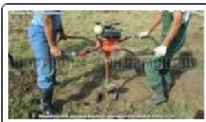
Ручное бурение свай мотобуром
