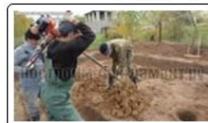
Фундамент ТИСЭ. Бурение свай
