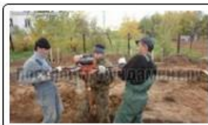
Бурение свай ТИСЭ
