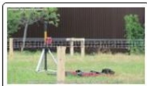
Разметка с применением лазерного нивелира
