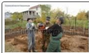
Ручное бурение мотобуром
