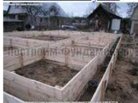
Опалубка для фундамента по технологии ТИСЭ
