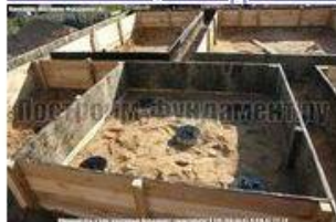
Сваи ТИСЭ под печь
