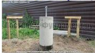
Сваи ТИСЭ, вывод из земли на 60-100 см
