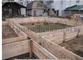
Установка опалубки
